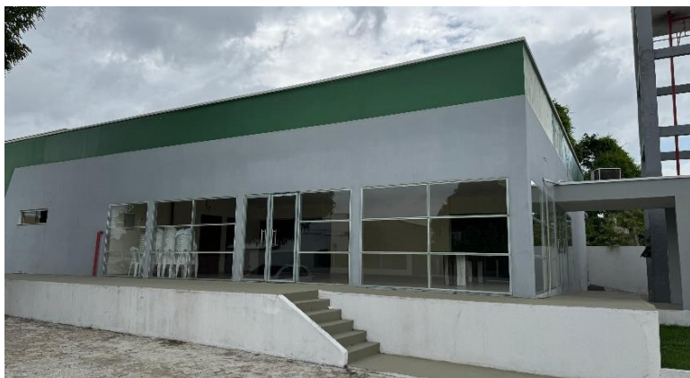
Vista Lateral do Bloco Administrativo/Gabinetes
